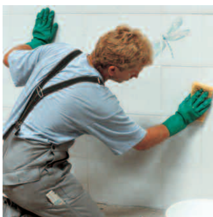
Torka av återstående bruk med en fuktig svamp.
