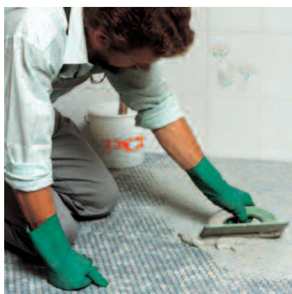
Använd en gummiskrapa för att fylla fogarna ordentligt.
