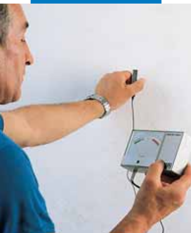
Kontroll av putsens fukthalt
