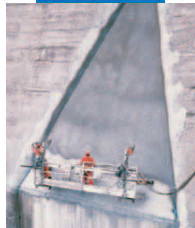
Exempel på sprutapplicering av Mapelastic på en damm
