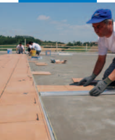
Plattsättning med Kerabond + Isolastic
