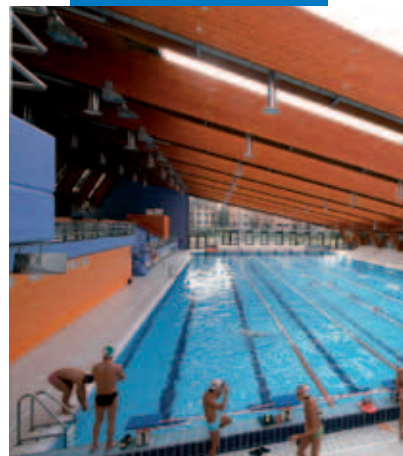
Simbassäng vattentätad med Mapelastic: Scarioni-badet - Milano - Italien
