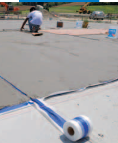
Vattentätning av massaunderlag med Mapelastic och Mapeband
