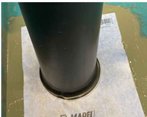
Montering av Mapeguard PC manschett med Mapeguard WP 2K Membrane
