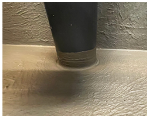
Mapeguard PC manschett applicerad med Mapeguard WP 2K Membrane upptill
