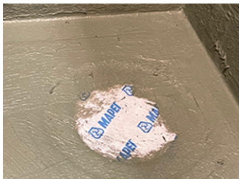
Mapeband B DC används för tätning runt golvbrunn. Mapeguard WP 2K Membrane appliceras på fleeceytan innan klämringskopplingen monteras
